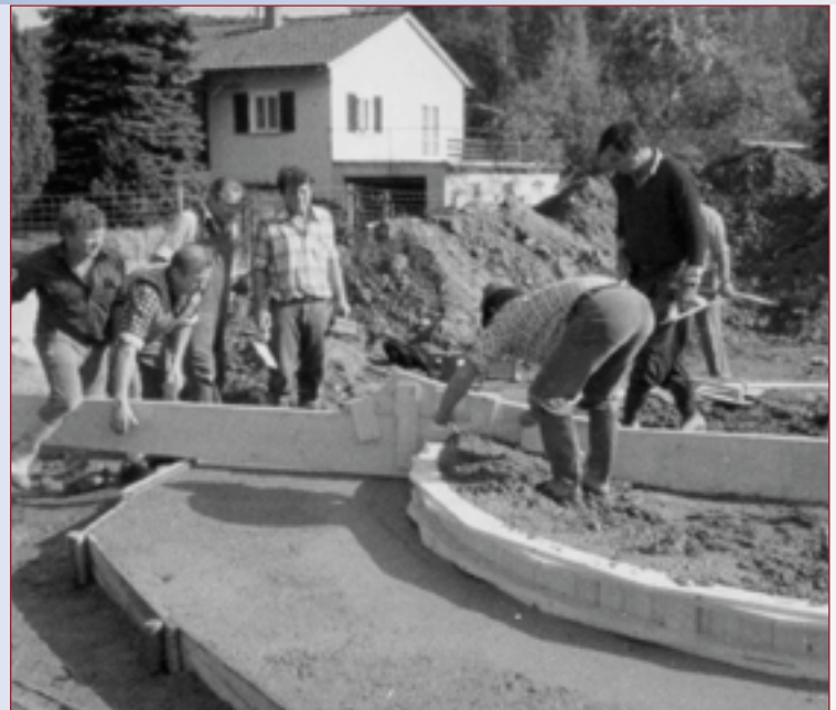
Exaktes Arbeiten ist Voraussetzung; der Bau des Brunnenbeckens war eine stramme Leistung unserer Holzhauer.
